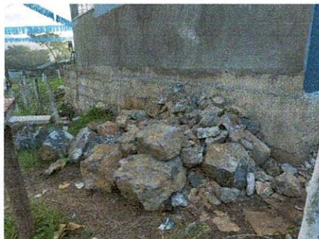
Foto 1: MURO DE CONTENCIÓN.
