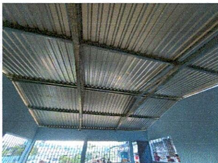
Foto 3: PINTURA EN PAREDES E INSTALACION DE VENTANALES Y PUERTA METALICA.
