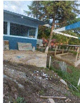
Foto 2: MURO DE CONTENCIÓN
